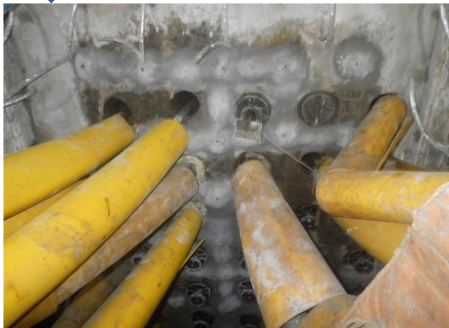
台座の取付け
