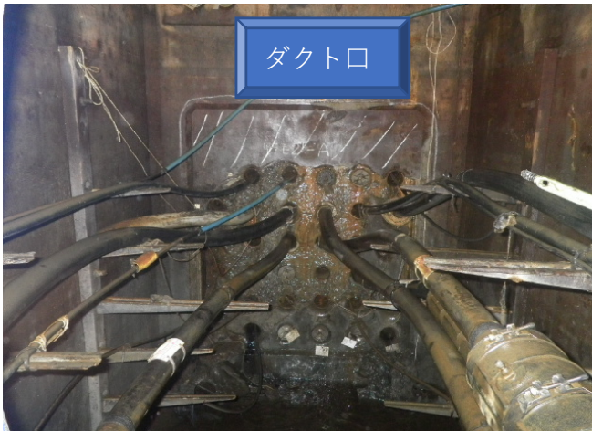
補修ダクト口
