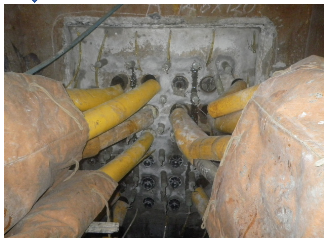
注入ポンプ取付け
