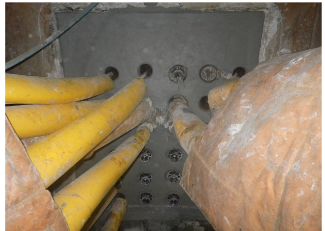
ダクト口仕上げ (ケーブル防護)
