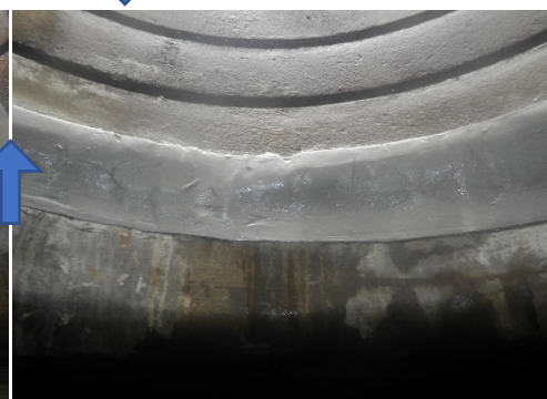
↓ 補修ヶ所の仕上げ2
