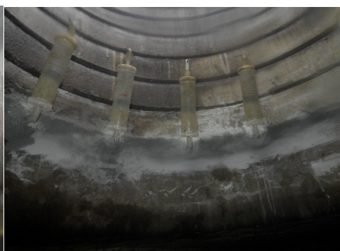
↓ 注入ポンプ取付け2
