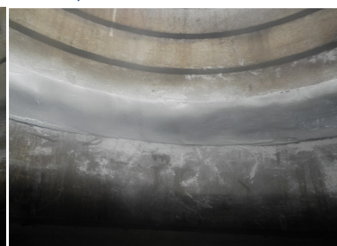
補修ヶ所の仕上げ3
