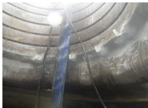
↓ 台座の取付け1
