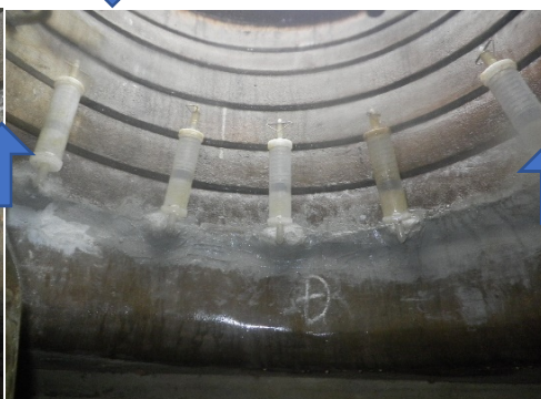
↓ 注入ポンプ取付け1
