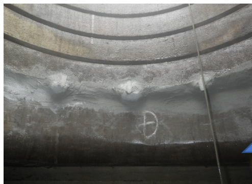
台座の取付け2
