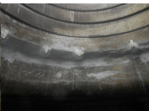
↙ 台座の取付け3
