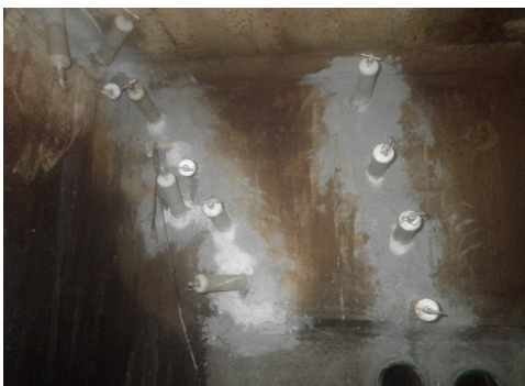
注入ポンプ取付け 1
