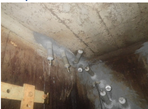
注入ポンプ取付け 2
