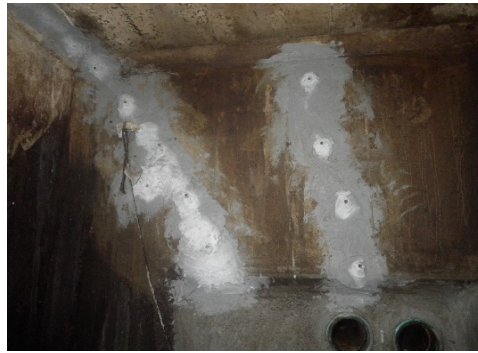
台座の取付け 1
