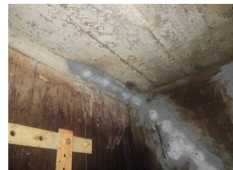
台座の取付け 2
