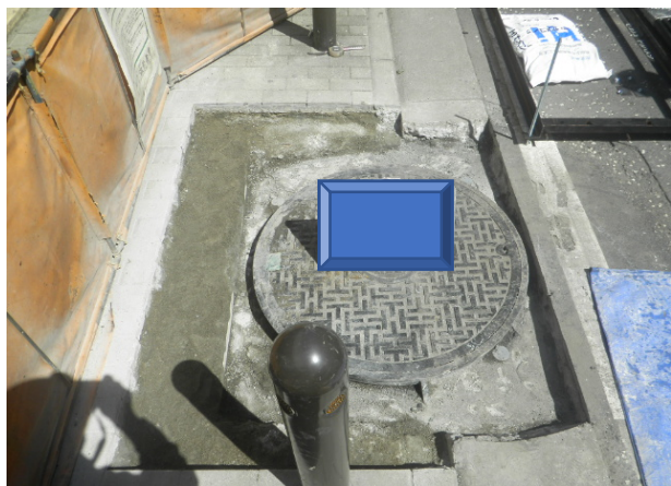
段差解消受枠の設置前
