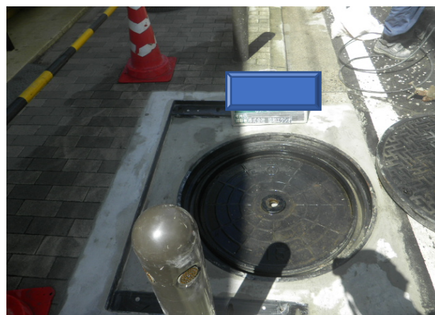
コンクリート打設状況 施錠蓋の設置状況
