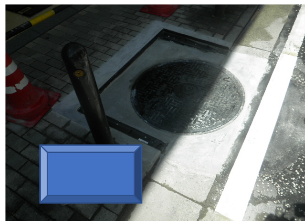
鉄蓋設置状況
