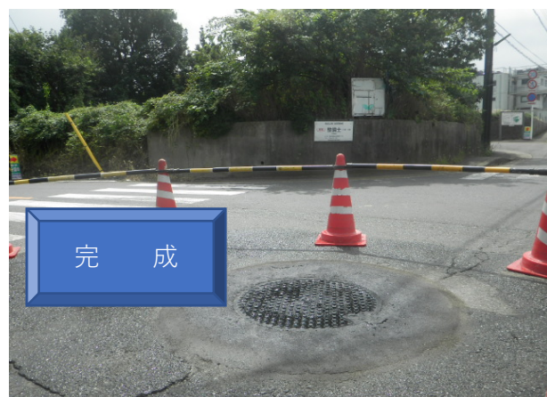
アスファルト舗装（加熱合材）
