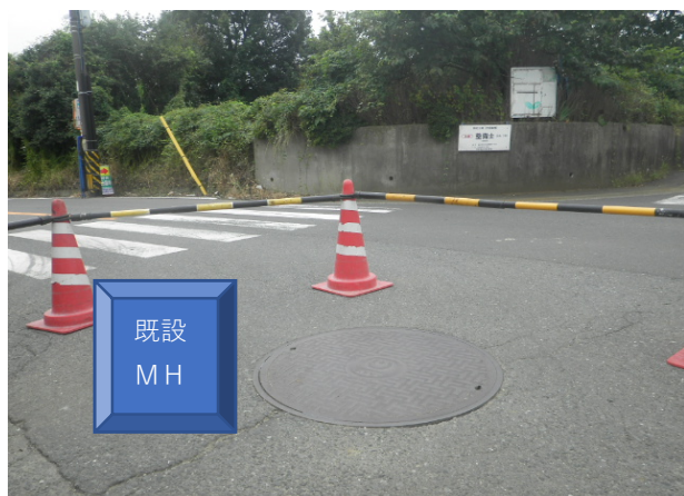
既設マンホール
