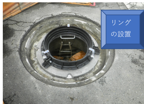
首部リングおよび受枠の設置
